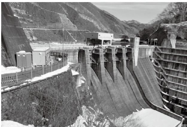
塗替え施工した群馬県團原ダム
