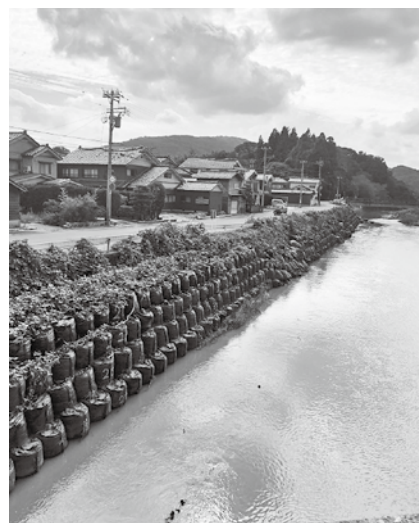
▲豪雨で氾濫した河川
