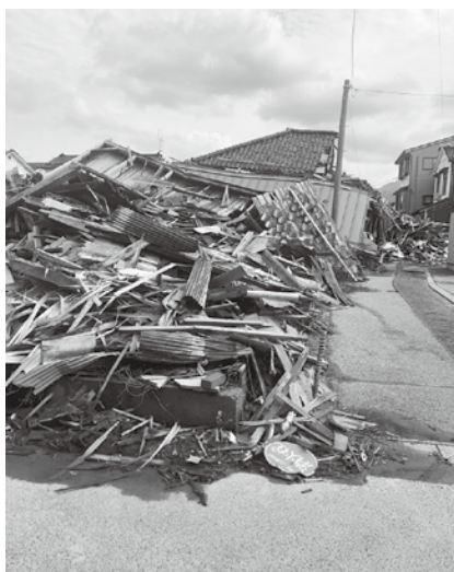
▲解体が進まない建物
