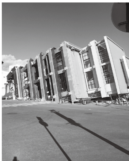
▲倒壊したビル
